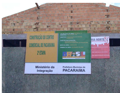
Segunda etapa da construção do Centro Comercial Rittler Lucena. Foto E. Braz, janeiro de 2009
