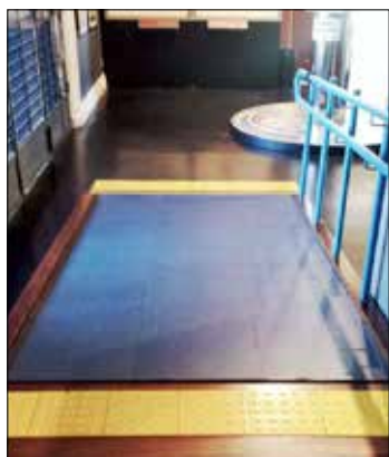
IMAGEM 6 Piso tátil no início e final da rampa
