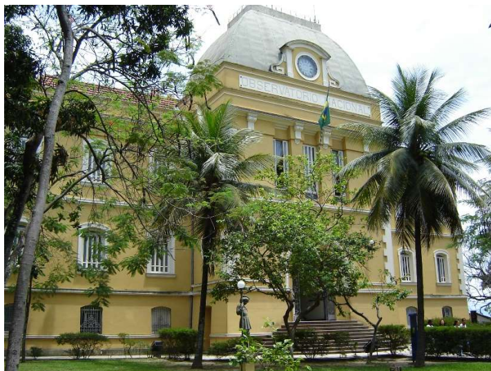
Figura 1: Prédio sede do Mast 2
